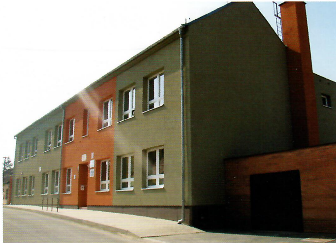
Budova Základní školy v Koberžicích
